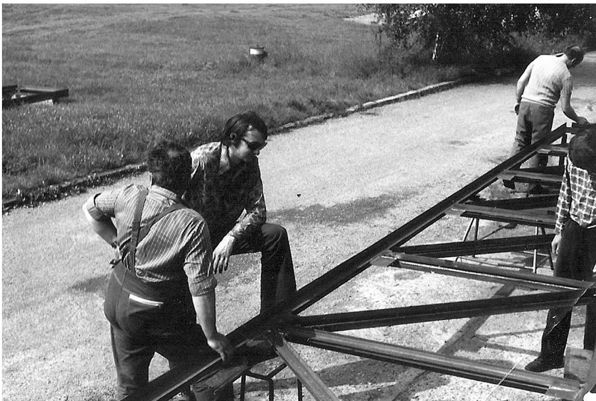
Příprava ocelové konstrukce prodloužení „dřevěného“ hangáru, zleva: Josef Vojtíšek, Jiří Pilný, Josef Křištof, Milan Eiselt; Nový Dvůr, září 1974
