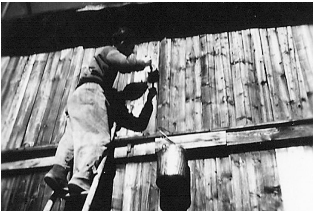
Zaručeně „ekologický“ nátěr dřevěného hangáru vyjetým olejem; Nový Dvůr, jaro 1952
